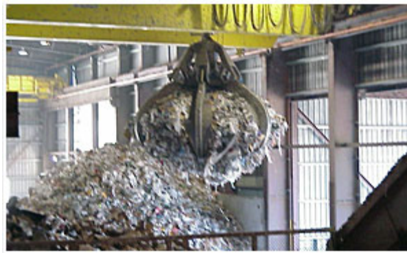
Hình 6.2: Cần cẩu chất thải rắn trong trạm trung chuyển
