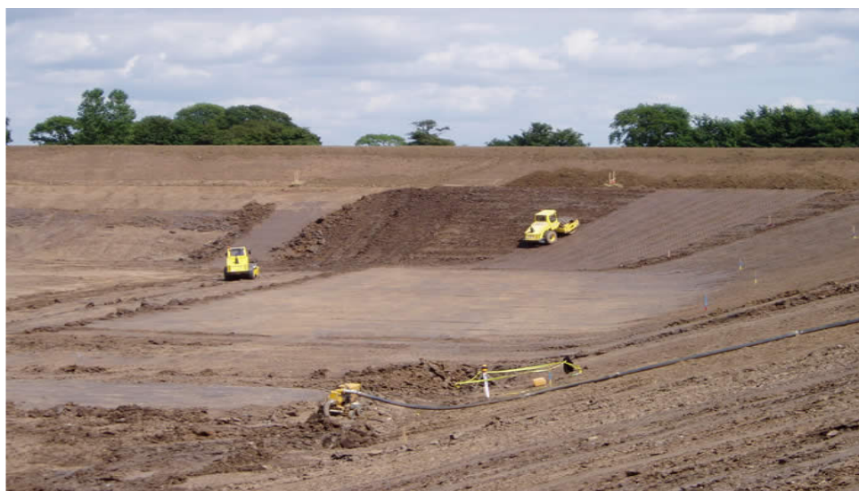
Hình 9.11 Thi công xây dựng bãi chôn lấp
