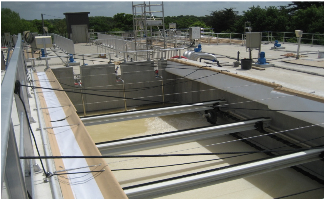
Hình 11: Nhà máy xử lý nước 31.200m 3 /ngày áp dụng FLOTOFILTER tại Finfarine – Pháp
