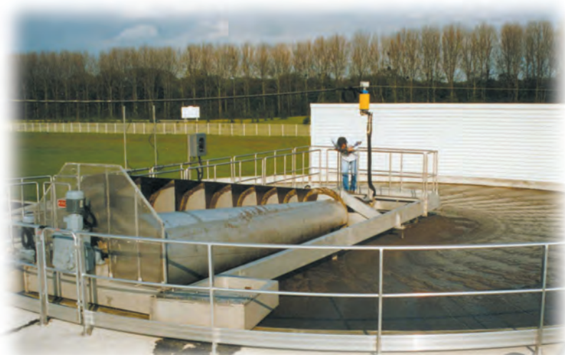
SDC 49 - Làm đặc bùn sinh học trong xử lý nước thải đô thị
